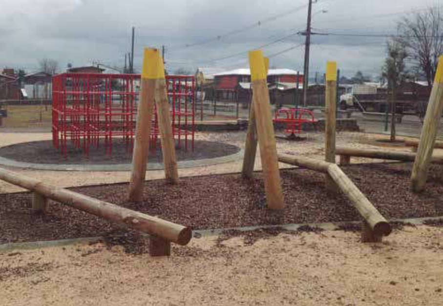
PAVIMENTOS BLANDOS EN PARQUE RIVERA VENECIA, TEMUCO
