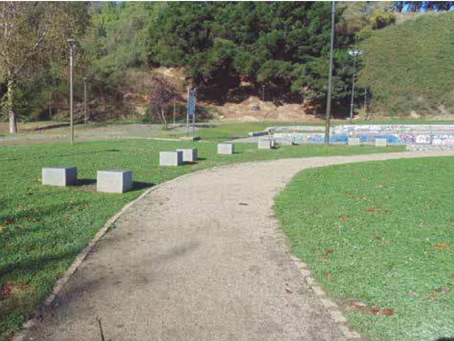
PAVIMENTO BLANDO EN PARQUE ECUADOR, CONCEPCIÓN
