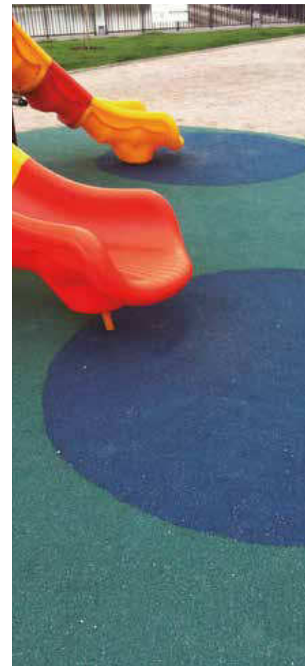
PAVIMENTO A BASE DE RECICLADO DE CAUCHO EN ÁREA DE JUEGOS INFANTILES, QUINTA NORMAL, SANTIAGO
