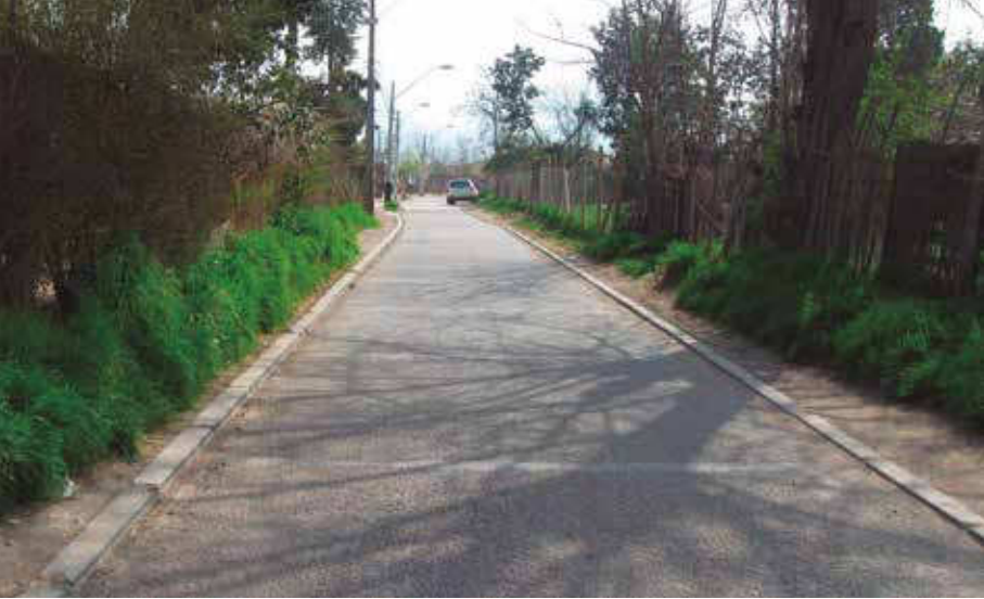
PASAJE DE HORMIGÓN DRENANTE, CALERA DE TANGO
