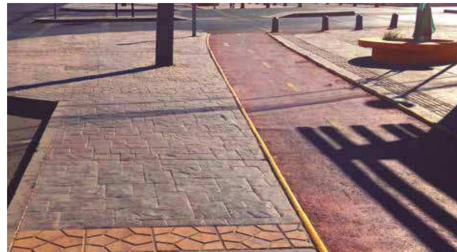
VEREDA EN PAVIMENTO IMPRESO Y CICLOVÍA, CALAMA
