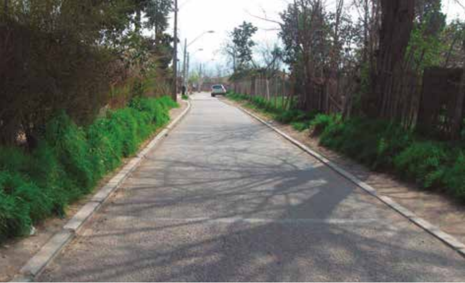
PASAJE DE HORMIGÓN DRENANTE, CALERA DE TANGO
