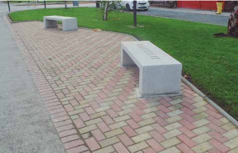
PAVIMENTO EN CORONEL
