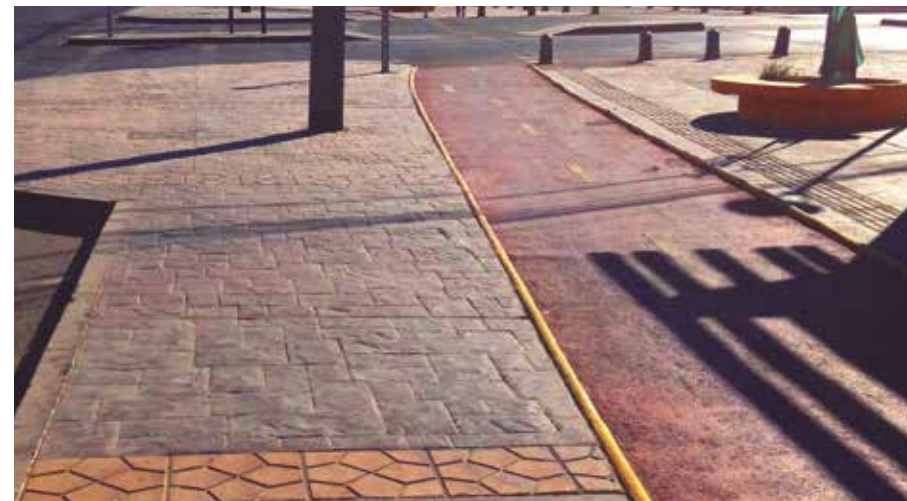
VEREDA EN PAVIMENTO IMPRESO Y CICLOVÍA, CALAMA
