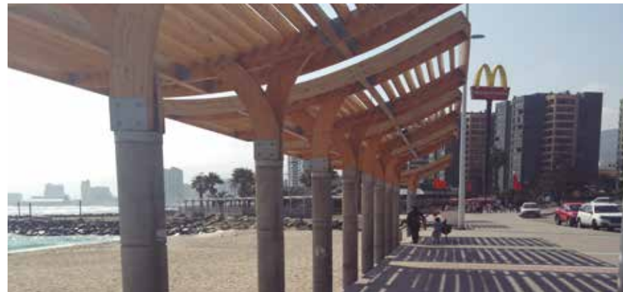
SOMBREADOR DE MADERA CON PROTECCIÓN UV, ANTOFAGASTA
