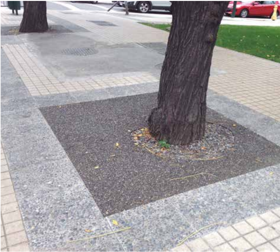
ALCORQUE DRENANTE, LAS CONDES, SANTIAGO
