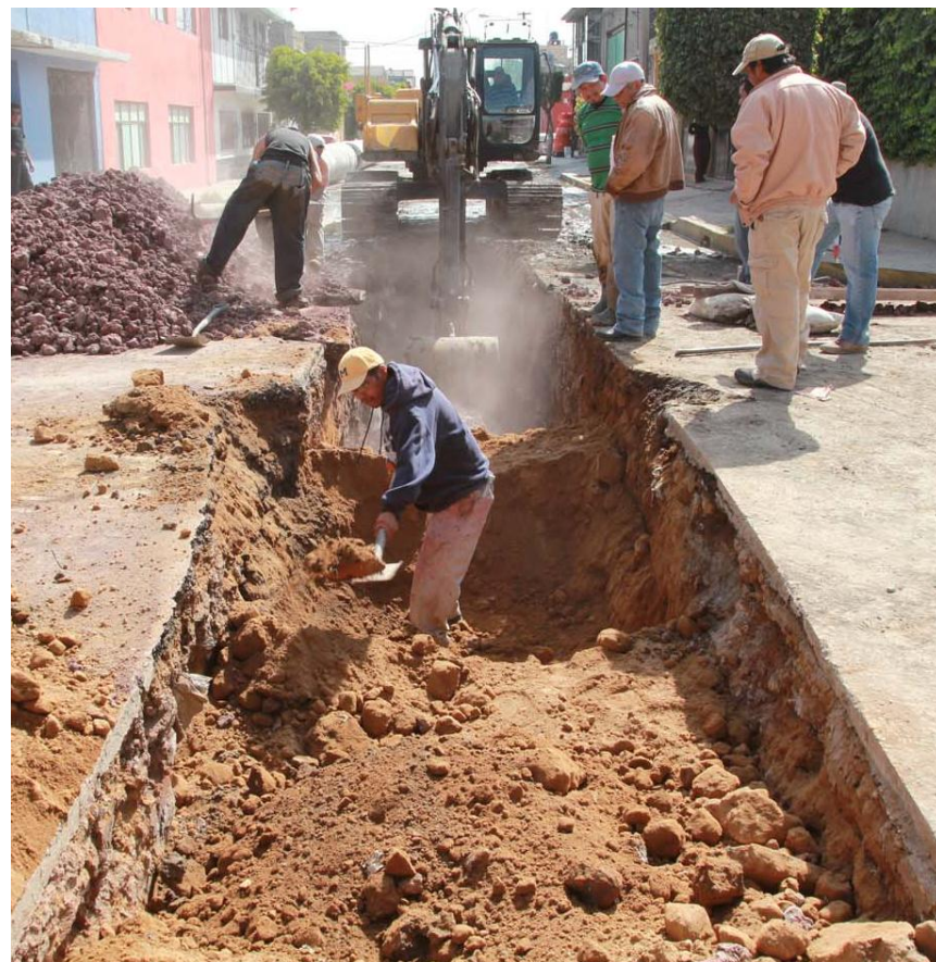
Construcción de pavimento, México
