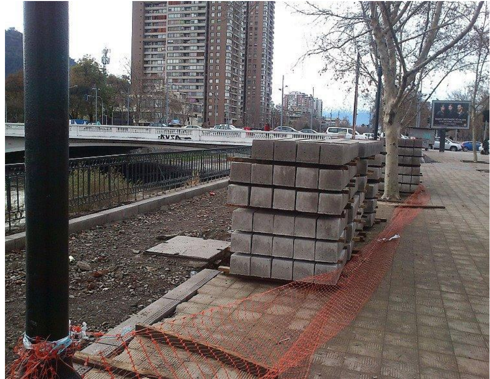
Pavimento como lugar de acopio materiales, Parque de Los Reyes, Santiago Fuente: www.skyscrapercity.com
