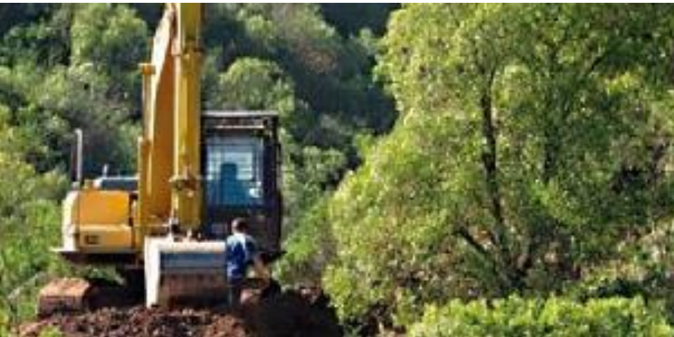
Construcción en Bosque El Panul Fuente: www.olca.cl
