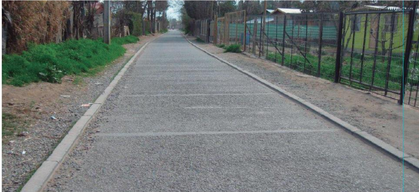
PAVIMENTO DE HORMIGÓN DRENANTE, CALERA DE TANGO
