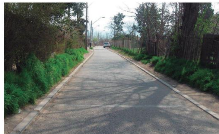
PASAJE DE HORMIGÓN DRENANTE, CALERA DE TANGO
