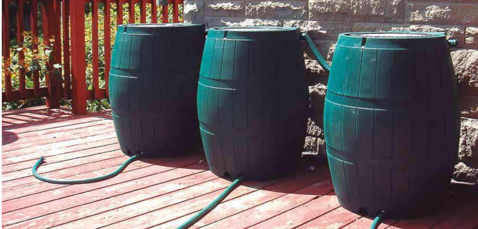
TANQUES DE ACUMULACIÓN AGUAS LLUVIAS
